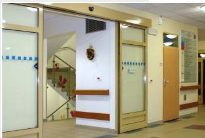
Automatické dveře s požární odolností
